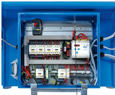
ABUS elsystem 3 med kontaktorstyring
